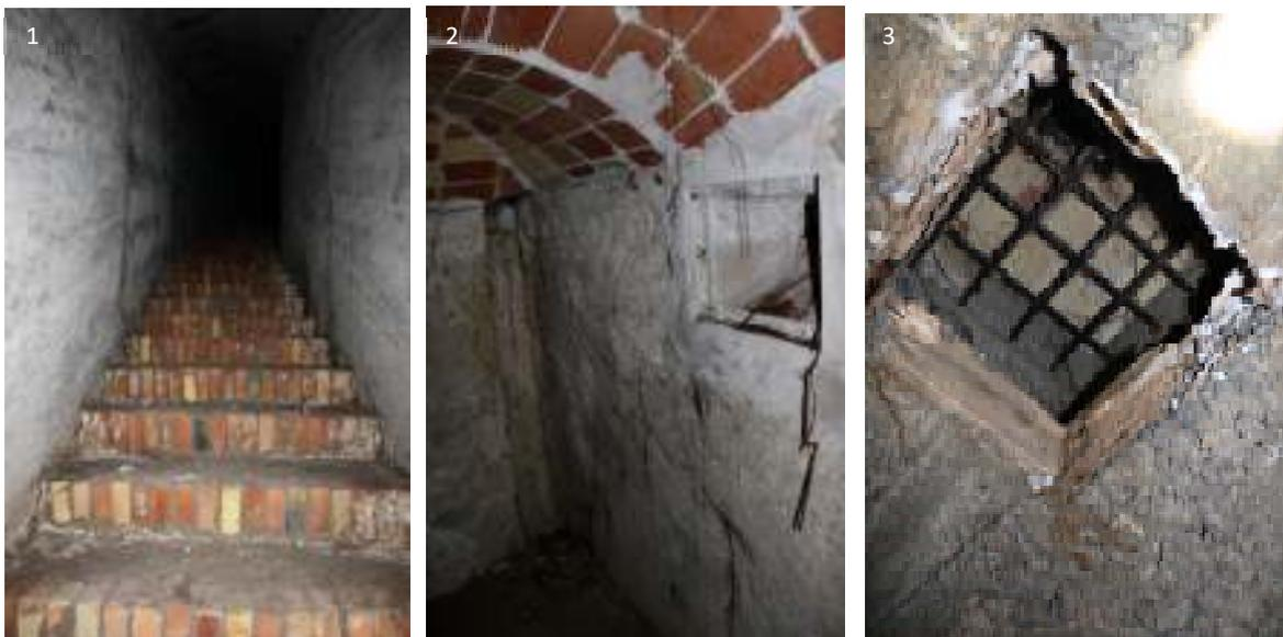
Img. 4.-Escaleras de peldaño de ladrillo macizo de acceso al refugio. 2.- Restos de la instalación eléctrica en escaleras. 3.- Conductos de ventilación.
